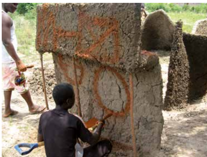
Construction d'un labyrinthe au Ghana.
